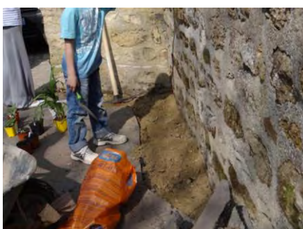
Photo 2 : La préparation d'un emplacement ; découpage du bitume, puis apport de terre végétale
