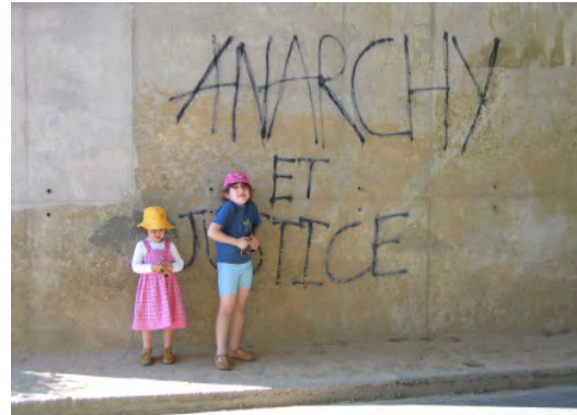
Nos campagnes aussi sont touchées par la « tagomanie » Ici le pont de la déviation sur le CD 43.
